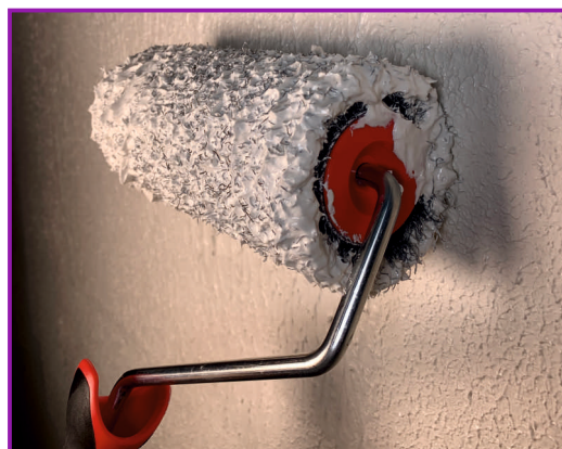
Nanášení stěrky válečkem na podklad
