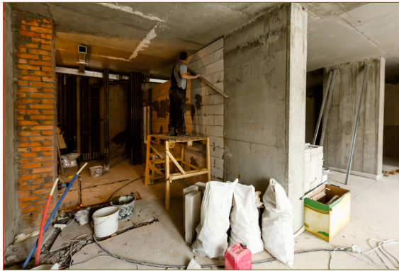
V průběhu rekonstrukce
