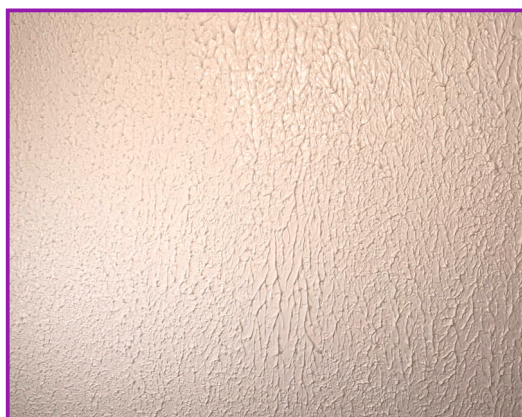
Detail rovnoměrně roztaženého materiálu
